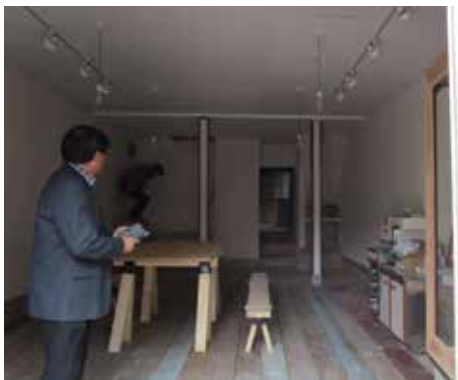
南伊豆町商店街の空き店舗改修の様子
