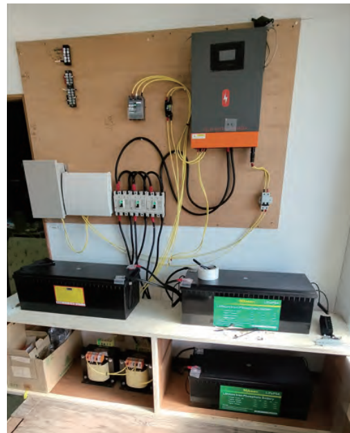
図6 蓄電システムの構築
