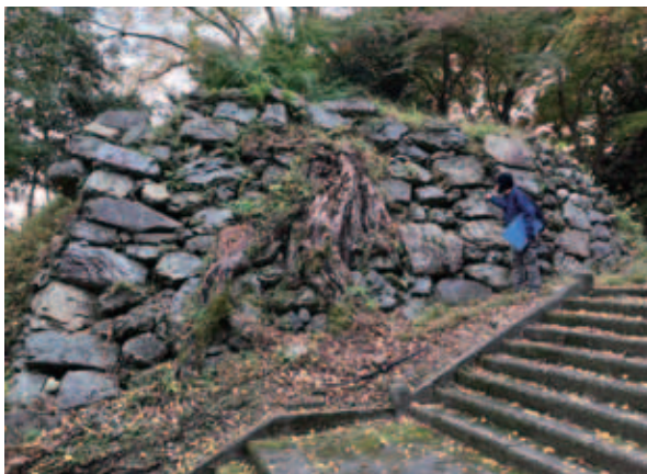
図7 調査風景（その5）
