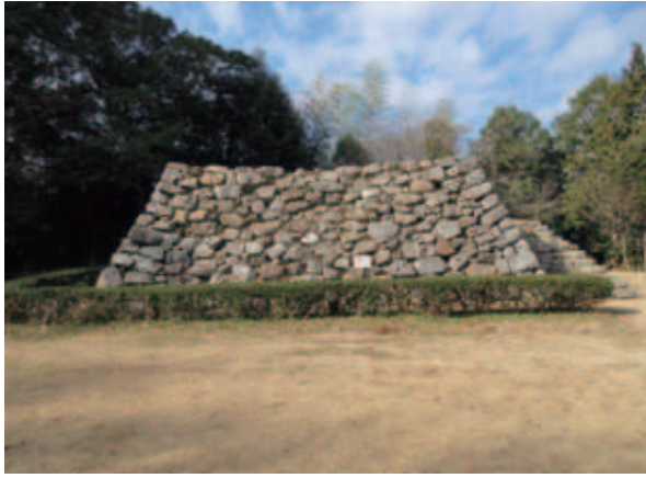
図12 調査した石垣① (N=275)
