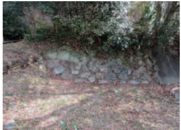
図33 調査した石垣㉓ (N=48)
