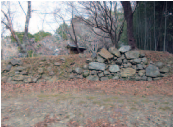
図21 調査した石垣⑪ (N=75)
