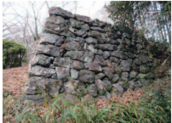
図26 調査した石垣⑯ (N=102)
