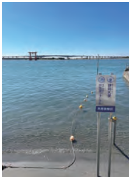
写真9 共同実験区の設置状況
