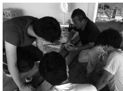
図2 地域の方と取り組む改修作業
