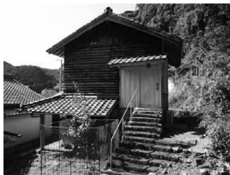
図3 水防建築「水揚げ小屋」（和歌山県古座川町）
