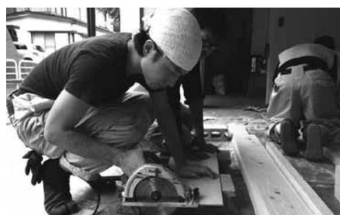
図1 空き家改修の作業風景
