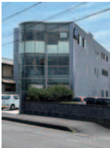
写真(左) 施設外観(3階)
