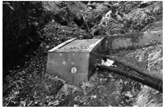
図7 完成した新しい取水口(2017年11月26日、竹内留哉撮影)
