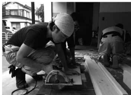
図10 改修作業の様子
