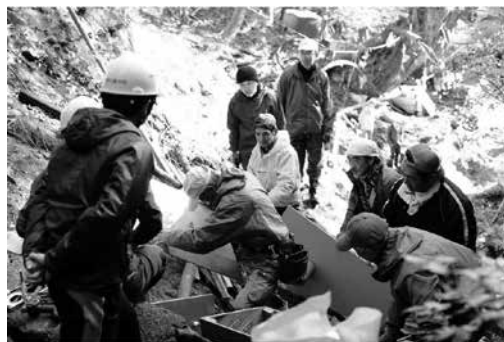
図4 型枠組み作業の風景（2017年11月19日、小柴撮影）
