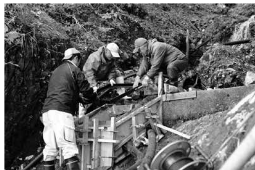
図6 グレーチングの枠をはめてこの日は終了（2017年11月19日、小柴撮影）
