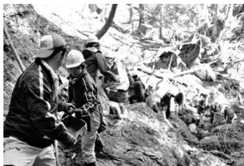
図5 セメントを運ぶバケツリレー（2017年11月19日、小柴撮影）
