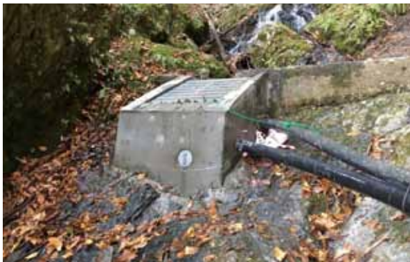
図 1 完成した新取水口
