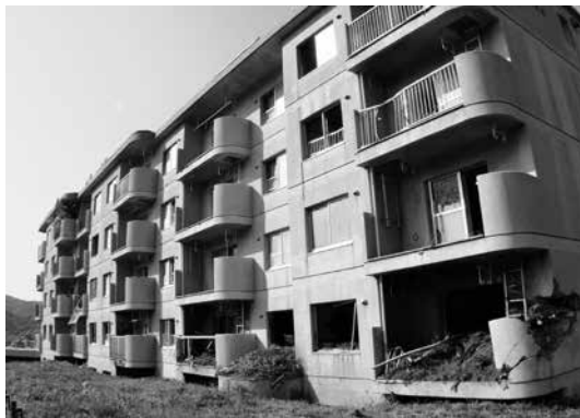
写真2 町宮アパート(桜が丘団地3号棟)
