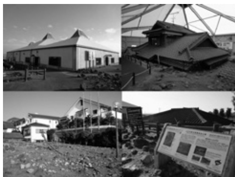
図8 土石流被災家屋保存公園整備(1999年)
