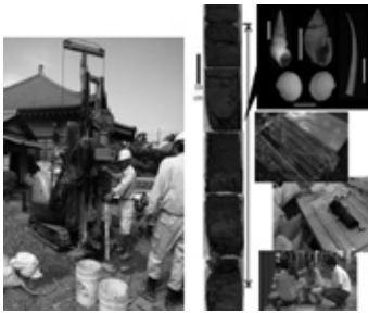
図30 ボーリングコアの掘削
