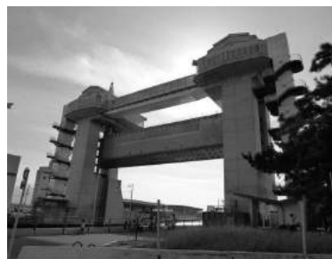
図7 沼津港の大型水門「びゅうお」
