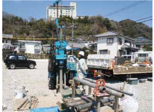
掘削機による掘削
